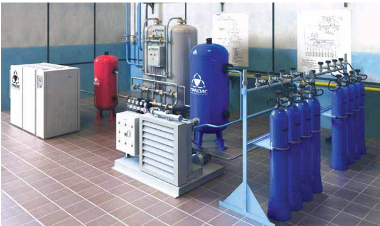
Производительность — 25 нм 3 /ч, 100 балл/сутки, чистота кислорода — 93-95%.
